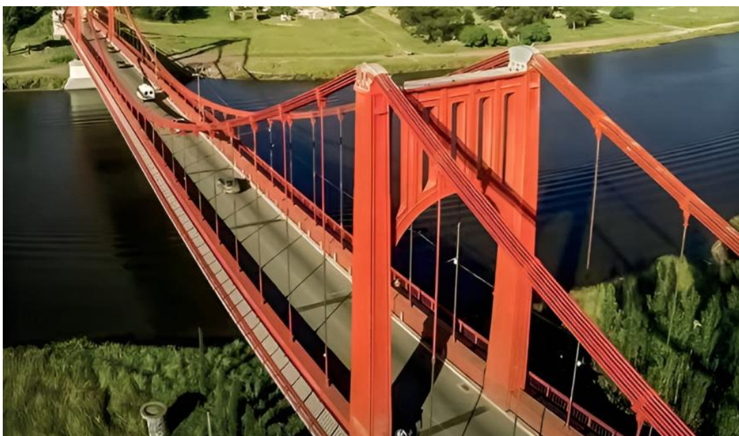
Puente Colgante Hipólito Yrigoyen, que cruza el Río Quequén Grande. Une a las ciudades de Necochea y Quequén.
